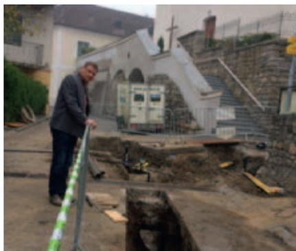
Im Zuge der Grabungsarbeiten für einen Fernwärmeanschluss wurde man auf einen Rohrbruch im Bereich Kreuzung Johannesstraße/Kirchenstraße und auf einen undichten Hydranten aufmerksam.
